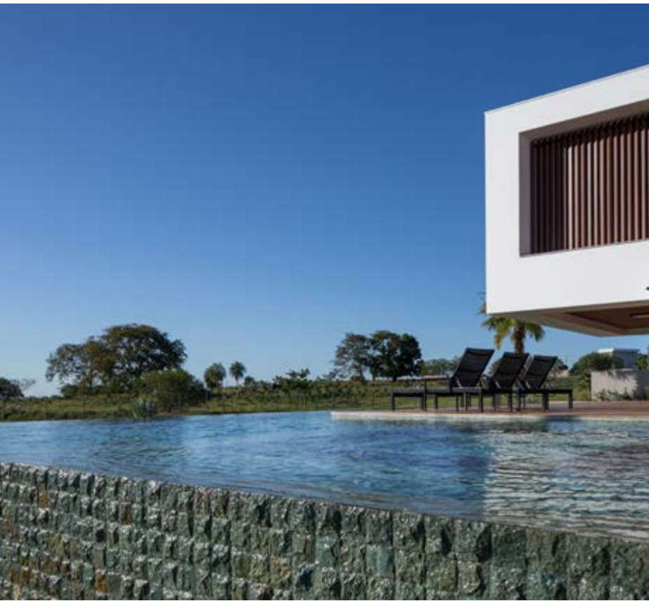
Andrade Oliveira Arquitetura - Foto: Jefferson Ohara - TS-061
